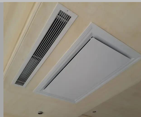
سقف زن سقف مسطح
